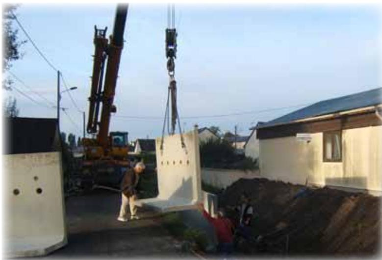
avons réalisé un mur de soutènement en béton. Du côté de la route, des panneaux sont posés sur une longueur de 38 m. Ils sont assez hauts pour une meilleure protection. Le long de ce ruisseau sécurisé,
