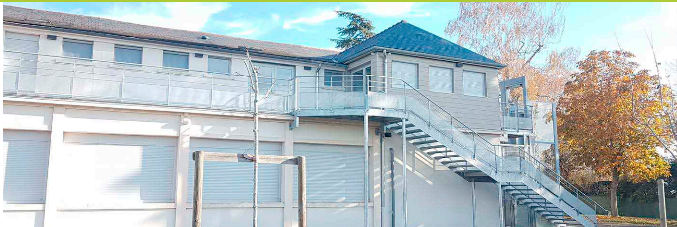
L'installation de la plateforme élévatrice permet l'accès aux personnes à mobilité réduite
